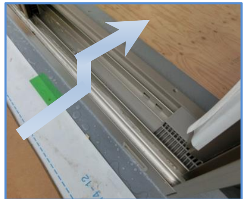
防水先施工の施工写真例
